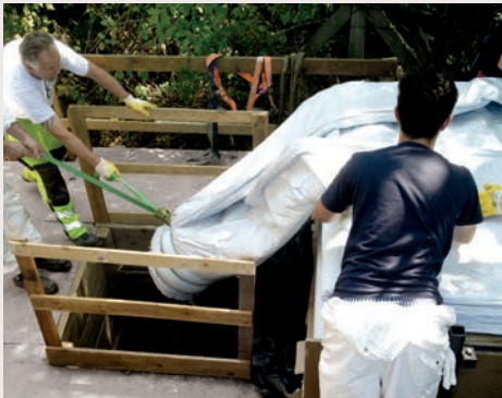
Impressionen von der Baustelle in Wiesbaden-Erbenheim: Einzug der Berolina-Liner, teils mittels des von BKP entwickelten mobilen Förderbands
