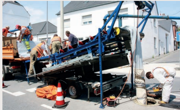
Impressionen von der Baustelle in Wiesbaden-Erbenheim: Einzug der Berolina-Liner, teils mittels des von BKP entwickelten mobilen Förderbands
